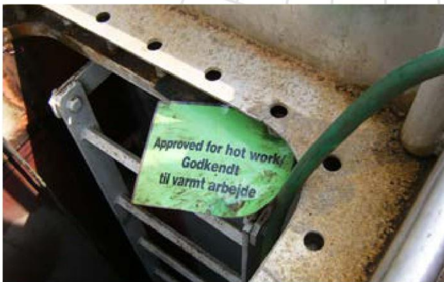
Metka potwierdzająca że zbiornik jest gotowy do pracy z ogniem.
